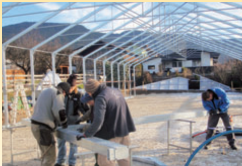
Die Bauarbeiten funktionierten reibungslos
